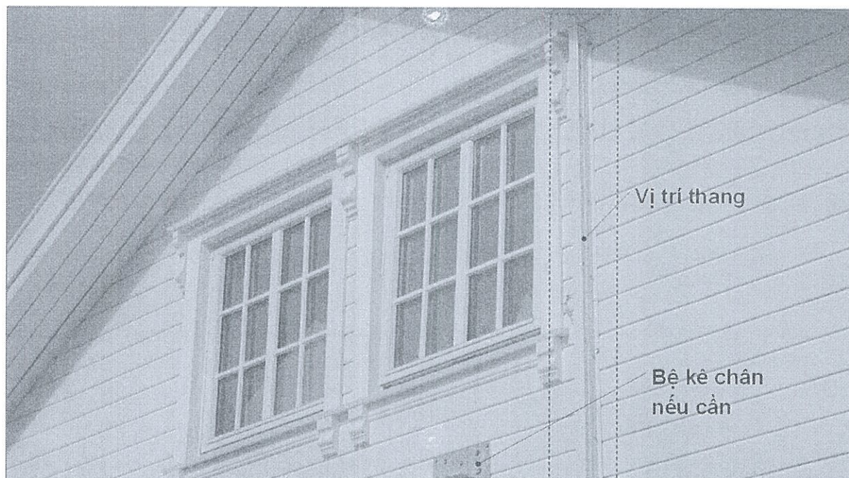
Thang ở trạng thái xếp dọc, ép sát bề mặt tường (vị trí lối ra khẩn cấp trên cùng)
