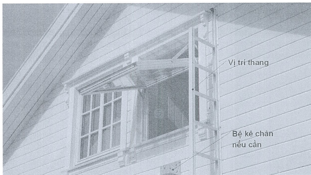
Thang ở trạng thái mở ra để sử dụng (vị trí lối ra khẩn cấp trên cùng)
